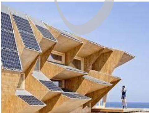
شکل شماره «۷۲»: استفاده از پنل‌های خورشیدی در ترکیبات و حجم معماری ساختمان، از محل‌های خاص در معماری برای بهره‌گیری در تولید انرژی استفاده می‌شود.
