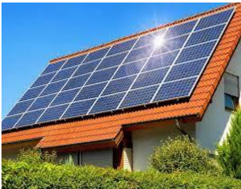
شکل شماره «۷۰»: استفاده از پنل‌های خورشیدی در بام ساختمان علاوه بر افزایش ظرفیت حرارتی بام همزمان برق مورد نیاز را تولید می‌کند.
