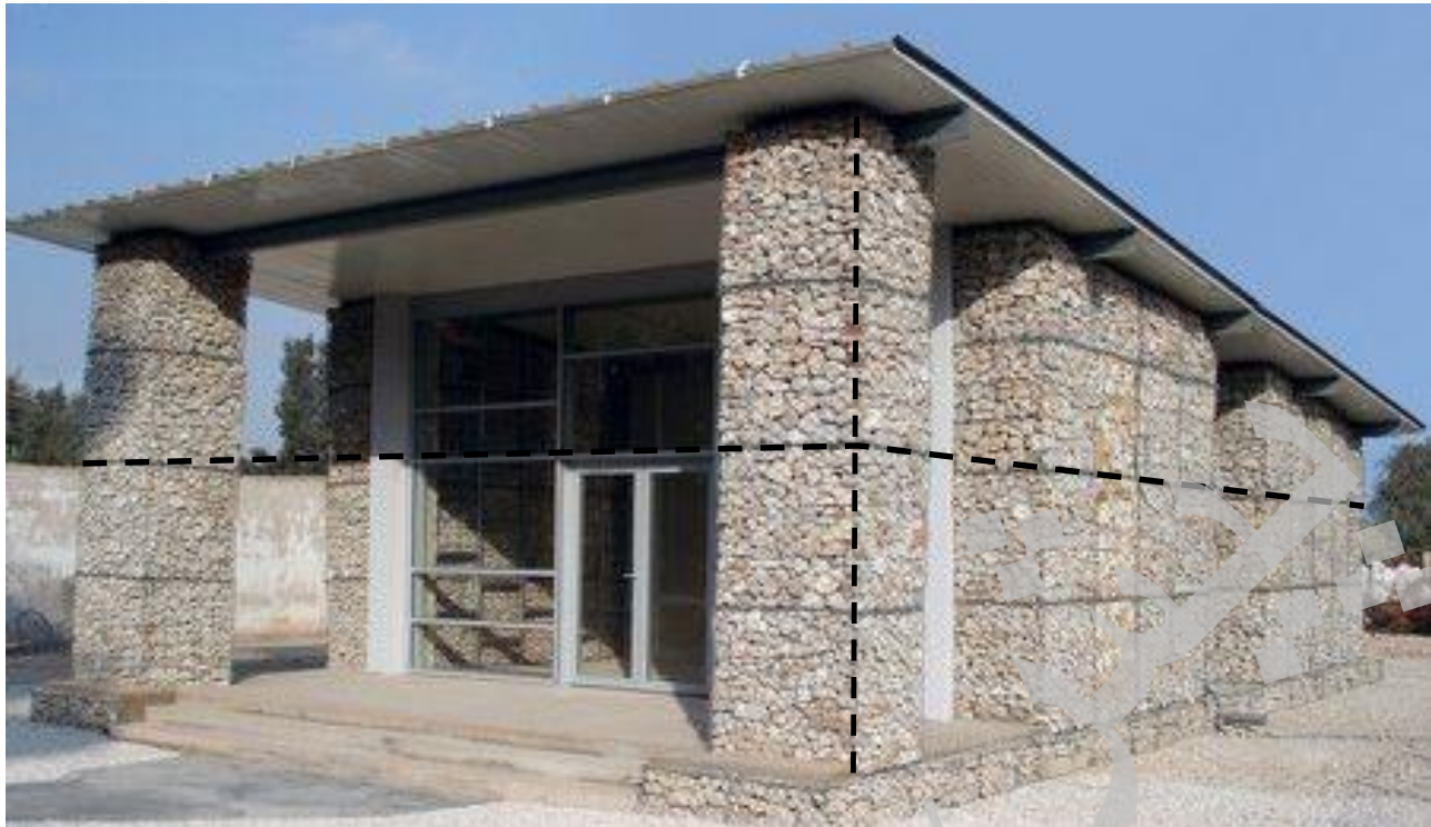
شکل شماره «۶۳»: استفاده از سنگ مالون در قطعه‌های حداکثر ۱۵ الی ۲۰ سانتیمتر برای پر کردن حجم دیوارهایی که با تورپهای فلزی به صورت سه بعدی شکل گرفته‌اند، ضخامت دیوار به دلیل جلوگیری از نفوذ باد و باران به داخل بنا می‌باشد. در این تصویر به دلیل افزایش جرم حجمی و وزنی ساختمان از پروفیل‌های سبک فلزی برای ایجاد مقاومت سازه‌ای دیوارها و نصب سقف استفاده شده است.
