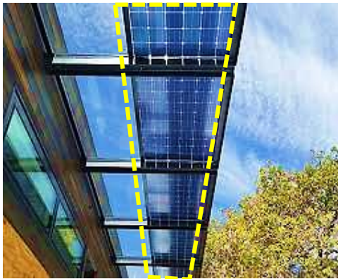
شکل شماره «۶۹»: استفاده از پنل‌های خورشیدی در سایبان ساختمان کنترل نور در اقلیم مربوطه را انجام و همزمان برق مورد نیاز را تولید می‌کند.
