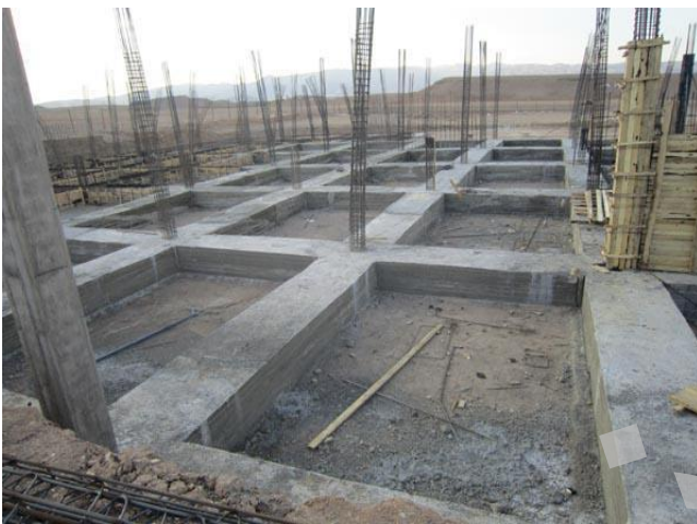
شکل شماره «۵۷»: فونداسیون روسطحی بتنی (سمت چپ) - فونداسیون روسطحی سنگی با ملات سیمان (سمت راست)
