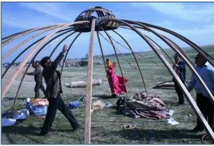
شکل شماره «۴۰»: نمونه‌ای از چادرهای ترکیبی از چوب و نی و نمد و پارچه ۸ به ترتیب از چپ به راست نحوه تکامل ساخت نشان داده شده است
