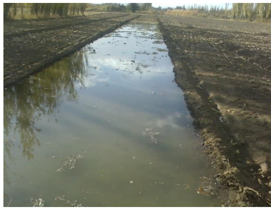
شاهد - خاک آب پس‌زدگی آب به خاطر شیب معکوس
